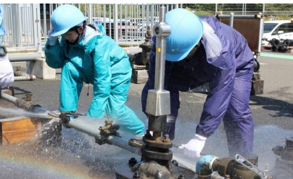
5. ②漏水修理
