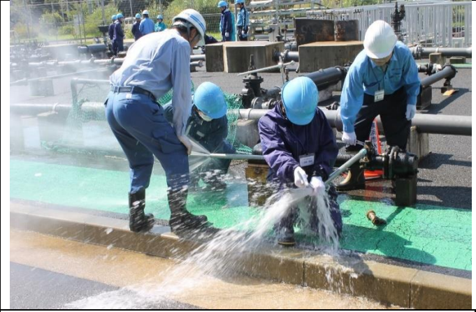
5. ③漏水修理
