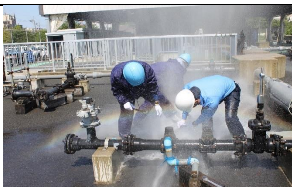
5. ①漏水修理
