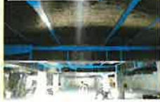
③貫索繊維貼付け
