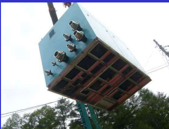
ラフタークレーンを使って設置
