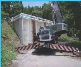
重機によって資機材を搬入
