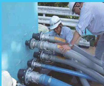
設置・据付は順調に進んだ
