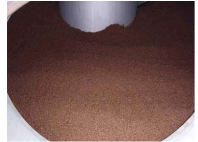
今回は鉄、マンガン原水のためマンガン砂を使用しました
