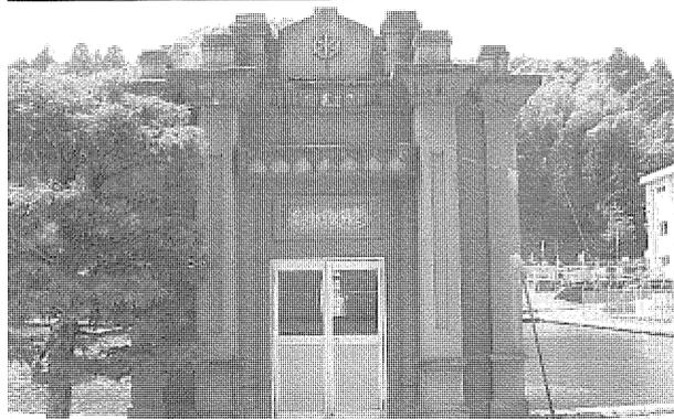
旧弁室及び着水井、着水井から濾過池へ原水を分配するための導水溝及び放水井、東西22m、南北31m規模の長方形平面とした濾過池6所、各濾過池から濾過水を集める集水井よりなる。
