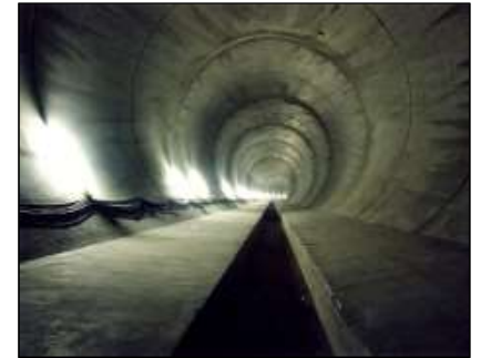
貯留管による下水流出抑制(川崎市)
