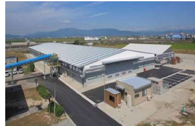
汚泥コンポスト化施設
