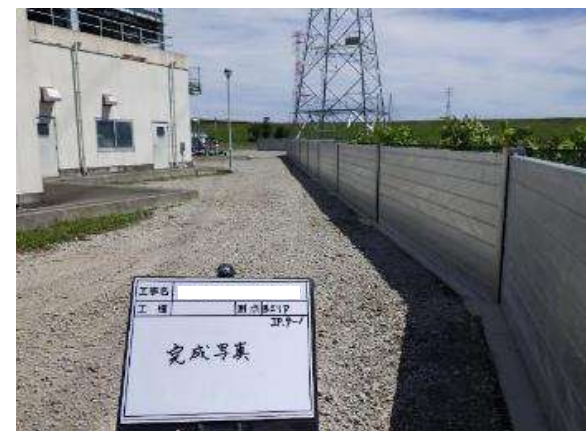
止水壁の設置
