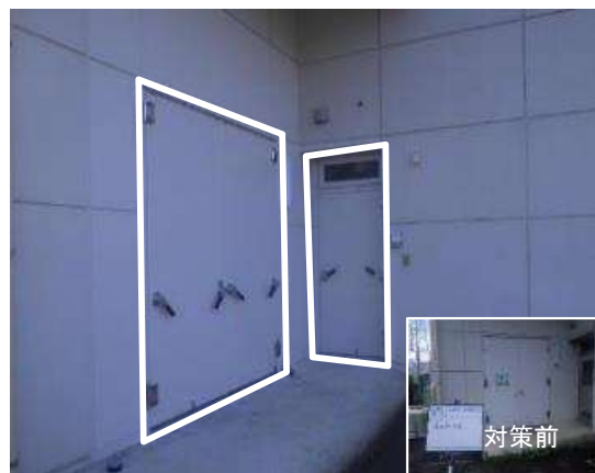
耐水扉の設置
