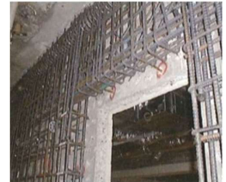
処理場・ポンプ場の躯体補強
