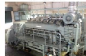
例：自家用発電機の整備
