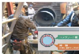
例：管路の点検補修
