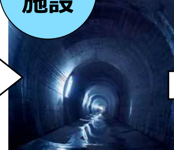
【導水トンネル】
