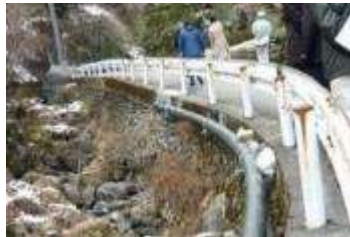
クイック配管 （露出配管）
