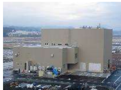
【汚泥資源化施設】 処理方式：炭化による資源化（処理能力：約7,800 ton/年）
