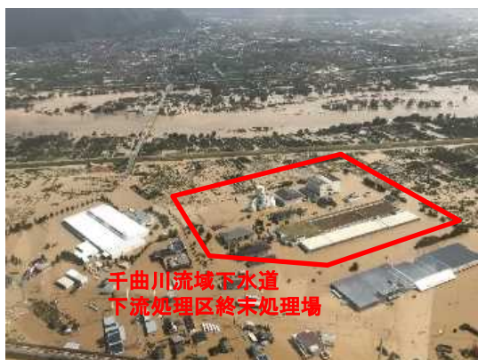
台風第19号による下水道施設の被害
