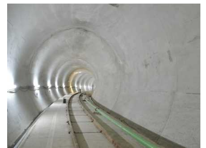
雨水貯留管施設の整備
