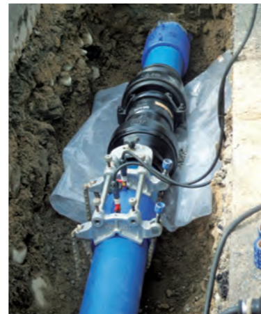
呼び径150設置状況
