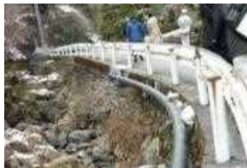
クイック配管 （露出配管）
