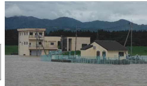
河川氾濫で浸水した取水井戸 (山形県雄花沢市) 60
