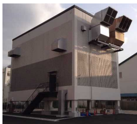
非常用自家発電設備のイメージ
