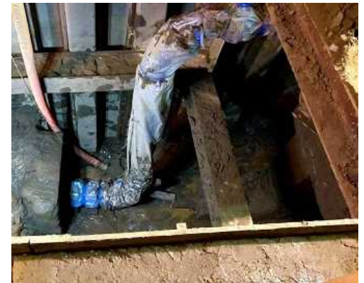
復旧した管路
