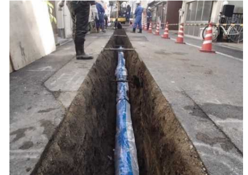
耐震管の布設イメージ
