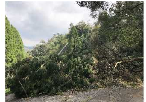
配水場門扉付近の被災
