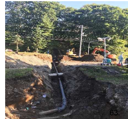
導水管補修状況 (北海道厚真町)
