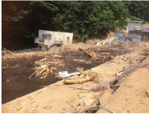
南予水道企業団 がれき(土砂や流木)が堆積し 浄水機能が停止した吉田浄水場
