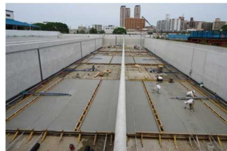
浄水場の耐震化工事 (内面からの壁等の補強)
