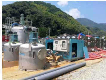
仮設浄水施設 により復旧 (約1ヶ月)
