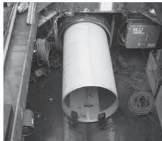
既設管1000mmに900Aを引込む
