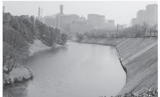
写真2 半蔵門の眼下に広がる桜田濠 写真右側の内堀通りは、濠に沿って長い下り坂になっている。濠の法面の手入れが行き届いているため、谷地を利用して濠が造られたことが実感できる。
