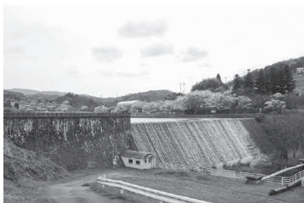
写真-1 千本ダム全景(工事前)
