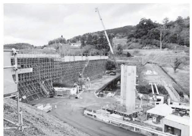
写真-2 施工時全景写真
