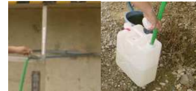
市民への配布（給水施設の設置）
