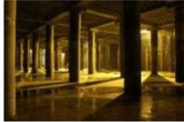
貯留施設の整備
