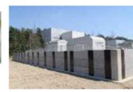
防水壁の設置
