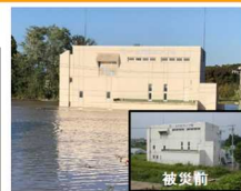
令和元年東日本台風で浸水したポンプ場 (福島県郡山市 水門町ポンプ場)
