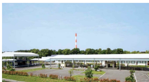
下水道技術実習センター
