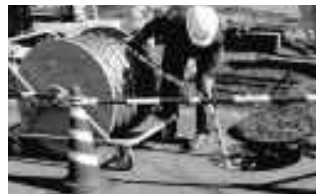
国土交通大臣賞 下水道圧送管路における硫酸腐食箇所の効果的な調査技術 (株)クボタ
