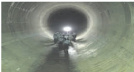
雨水貯留管の整備
