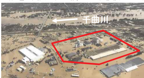
長野県 千曲川流域下流処理区終末処理場
