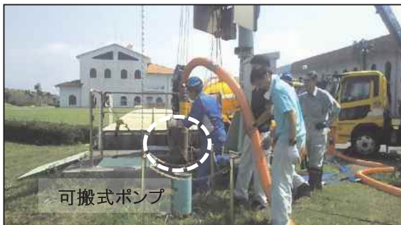
可搬式ポンプ、発電機の設置
