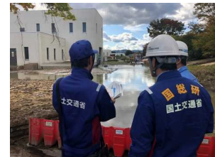
浸水被害を受けた下水処理場
