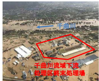
浸水した下水処理場 (長野県 千曲川下流処理区)
