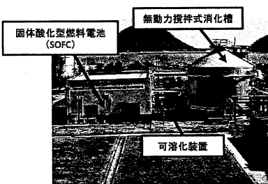
実証施設① (唐津市)
