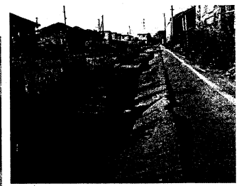
下水管被災による道路陥没(城南町)
