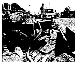
下水管破断箇所の応急対応(阿蘇市)
