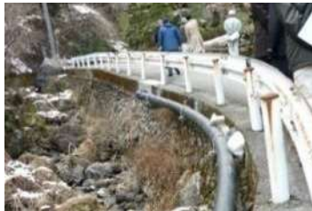
クイック配管 (露出配管)
