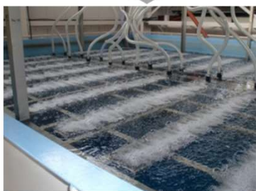
効率的な散気装置導入による省エネ化
