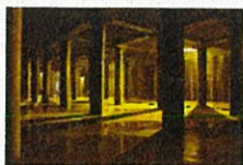
貯留施設（福岡市）
