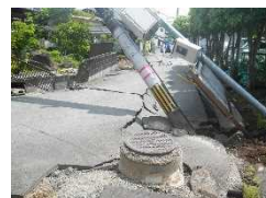
地盤の液状化による下水管の被害と復旧後 (熊本県益城町)
