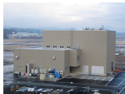
【汚泥資源化施設概要】 処理方式:炭化による資源化 処理能力:約7,800 ton/年
