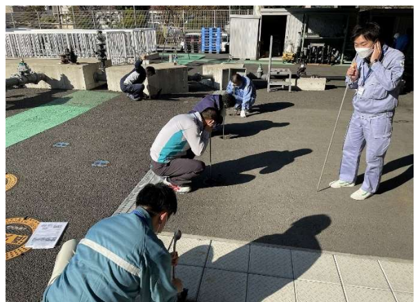
漏水調査研修（音調棒 通称耳かき）その2
