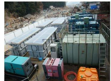
ユニット型膜処理システムによる処理場と別位置での応急対応状況(陸前高田市)
