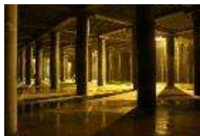
貯留施設（福岡市）
