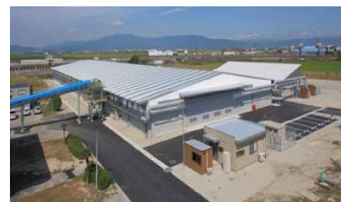
汚泥コンポスト化施設
