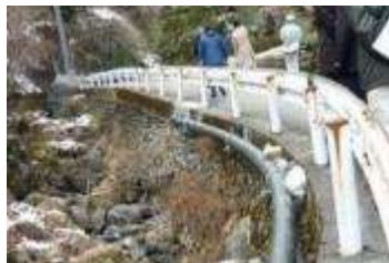
クイック配管 (露出配管)
