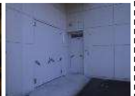
耐水扉の設置 （広島県三原市）
