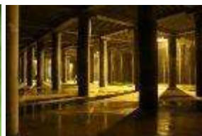
貯留施設（福岡市）
