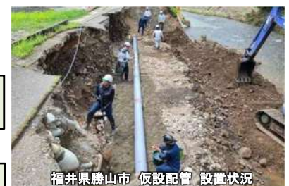
福井県勝山市 仮設配管 設置状況
