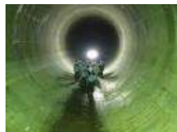
雨水貯留管（東京都）
