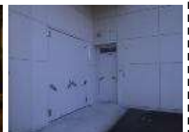
耐水扉の設置 （広島県三原市）
