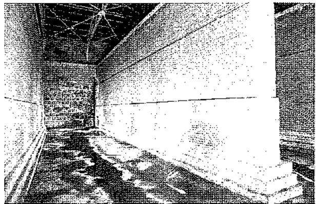
また、配水池上屋は大正15年に建てられたレンガ造で、屋根は鉄骨トラス組のトタン葺。正面中央入口は、上部にアーチを施したロマネスク風の洒落たデザインとなっている。(写真-4)
