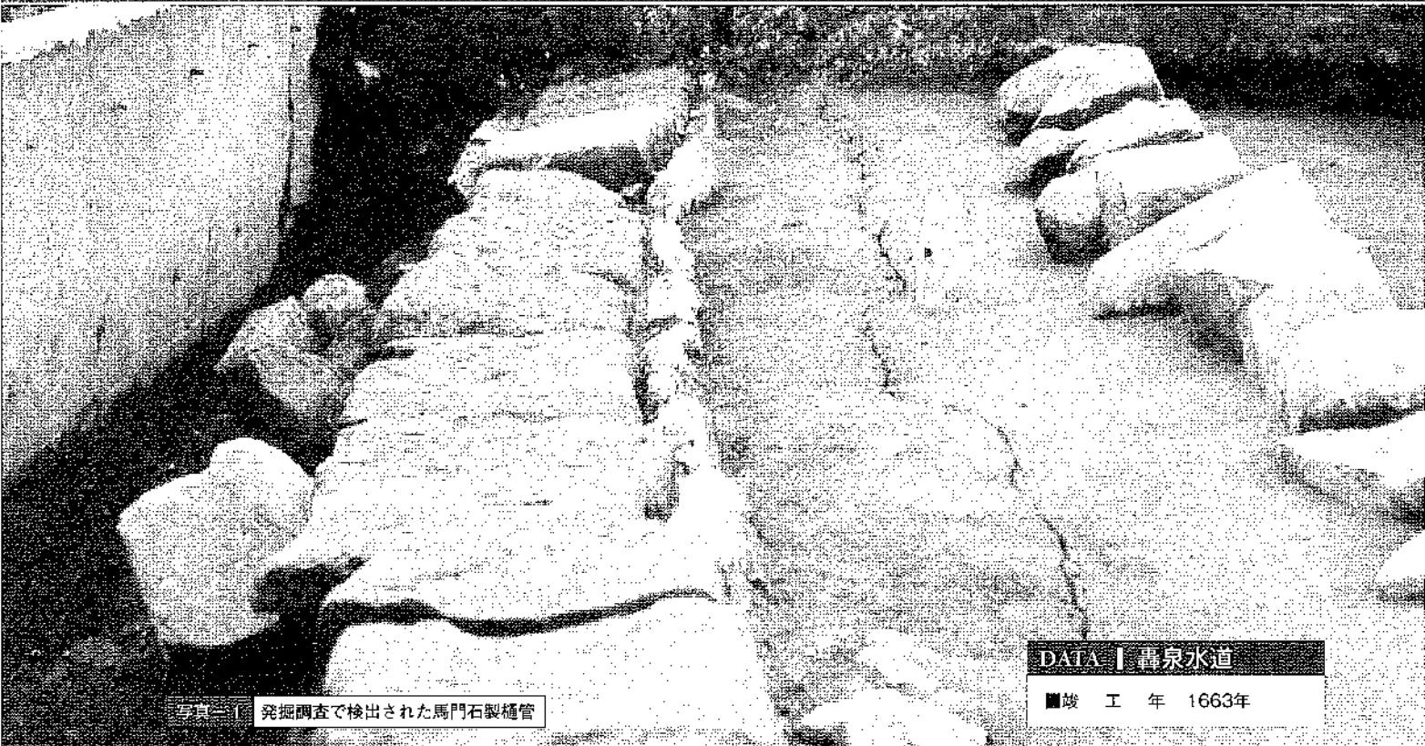
写真-1 発掘調査で検出された馬門石製樋管
